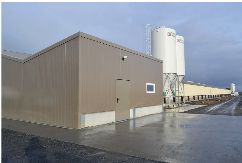
Le bâtiment avec ses 120 m de long par 24 m de large et ses trois salles d'élevage en enfilade, accueille 6 000 reproductrices dindes et quelque 400 mâles reproducteurs.
